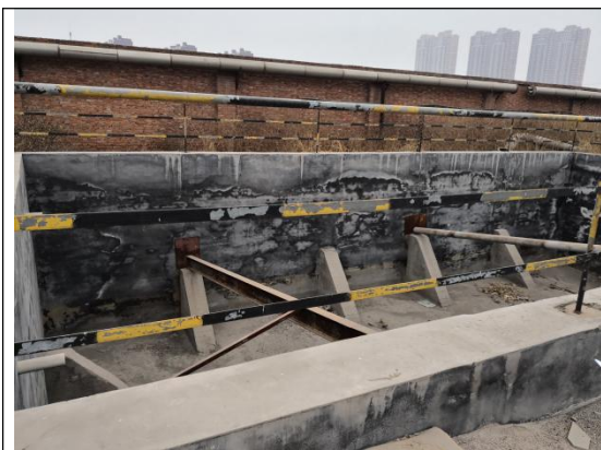
厂区西南处事故水池 池底防渗完整，无破损
